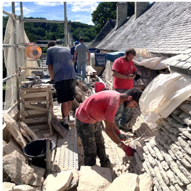
Restauration du toit en lauze du Thouron
